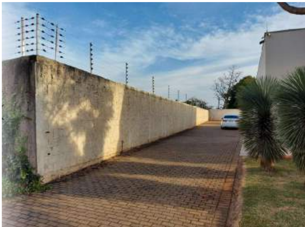
Figura 136: Pista que circunda infraestrutura de velório.
