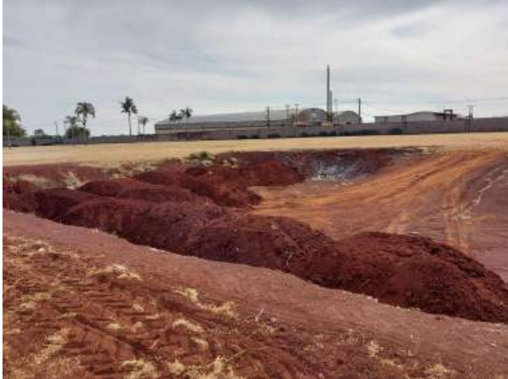
Figura 189: Área em construção de 3 jazigos sem acesso.
