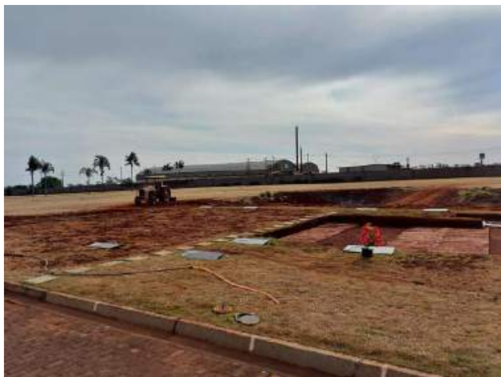
Figura 188: Vista da área com jazigos 6 gavetas com acesso, área em construção de 3 gavetas sem acesso.
