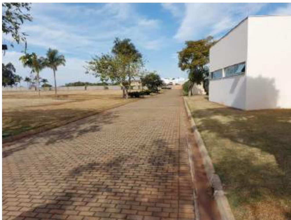
Figura 151: Arruamento interno cemitério.
