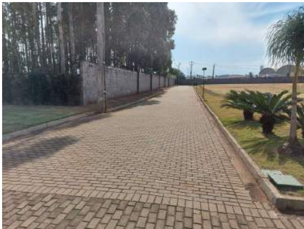
Figura 161: Arruamento interno cemitério.
