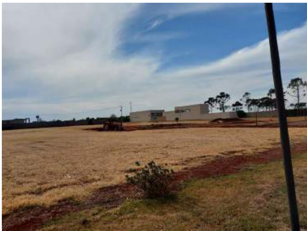
Figura 179: Vista da área com jazigos de 6 gavetas com acesso, área em construção de jazigos com 3 gavetas sem acesso, e aos fundos o prédio do crematório e funerária.
