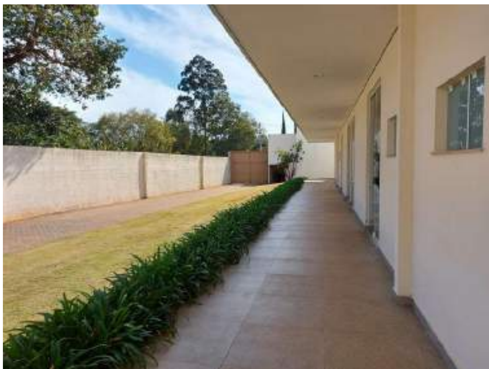
Figura 72: Circulação coberta atrás das salas de velório.
