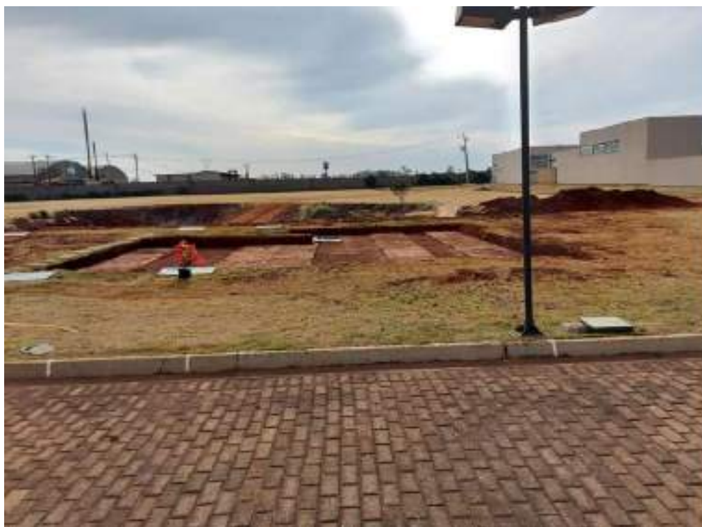
Figura 187: Vista da área com jazigos de 6 gavetas com acesso, área em construção de 3 gavetas sem acesso, e aos fundos o prédio do crematório e funerária.
