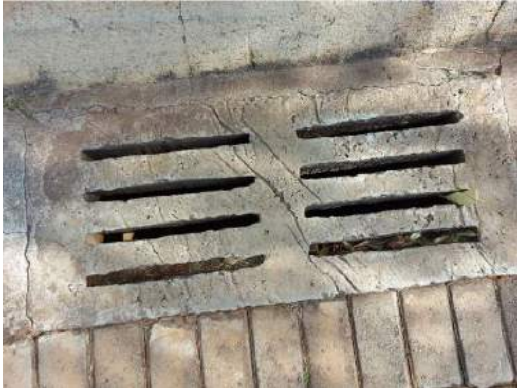
Figura 155: Bueiro do arruamento do cemitério.
