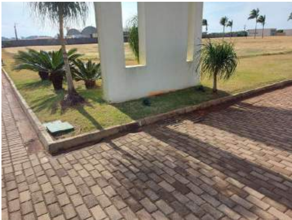
Figura 160: Arruamento interno cemitério.
