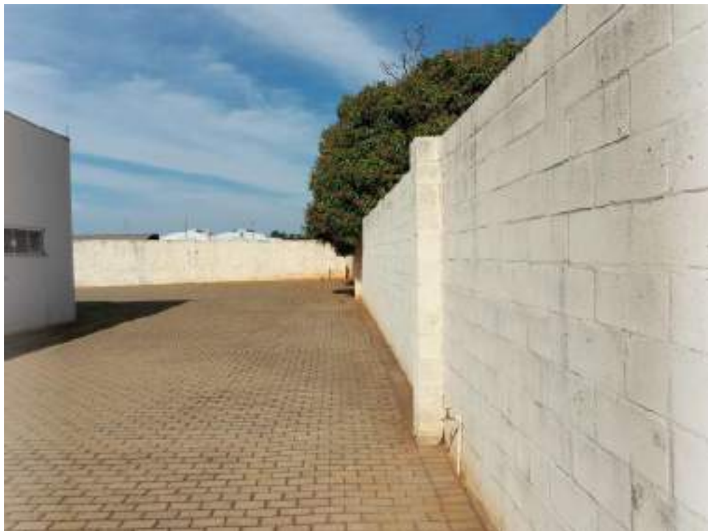
Figura 135: Pista que circunda infraestrutura de velório.
