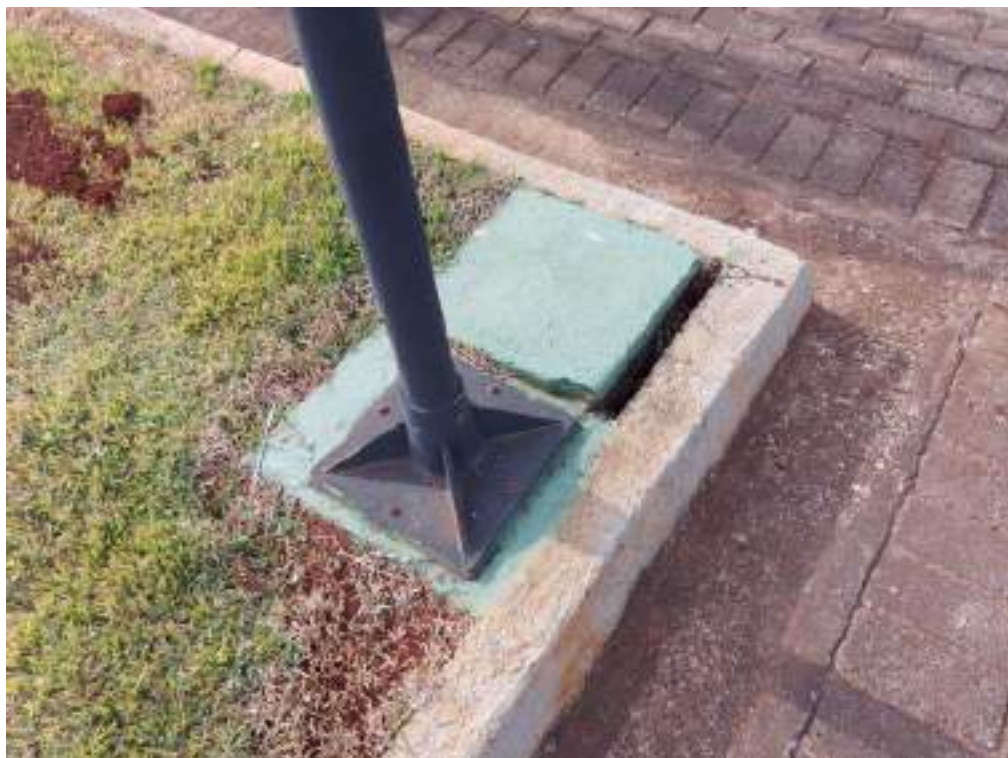
Figura 183: Parte elétrica da iluminação.
