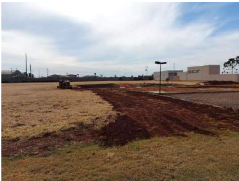
Figura 181: Vista da área com jazigos de 6 gavetas com acesso, área em construção de 3 gavetas sem acesso, e aos fundos o prédio do crematório e funerária.
