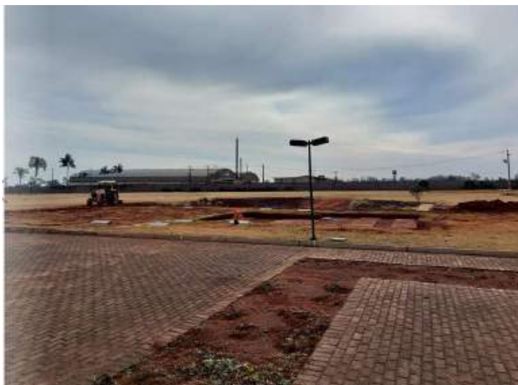
Figura 186: Vista da área com jazigos de 6 gavetas com acesso, área em construção de 3 gavetas sem acesso.
