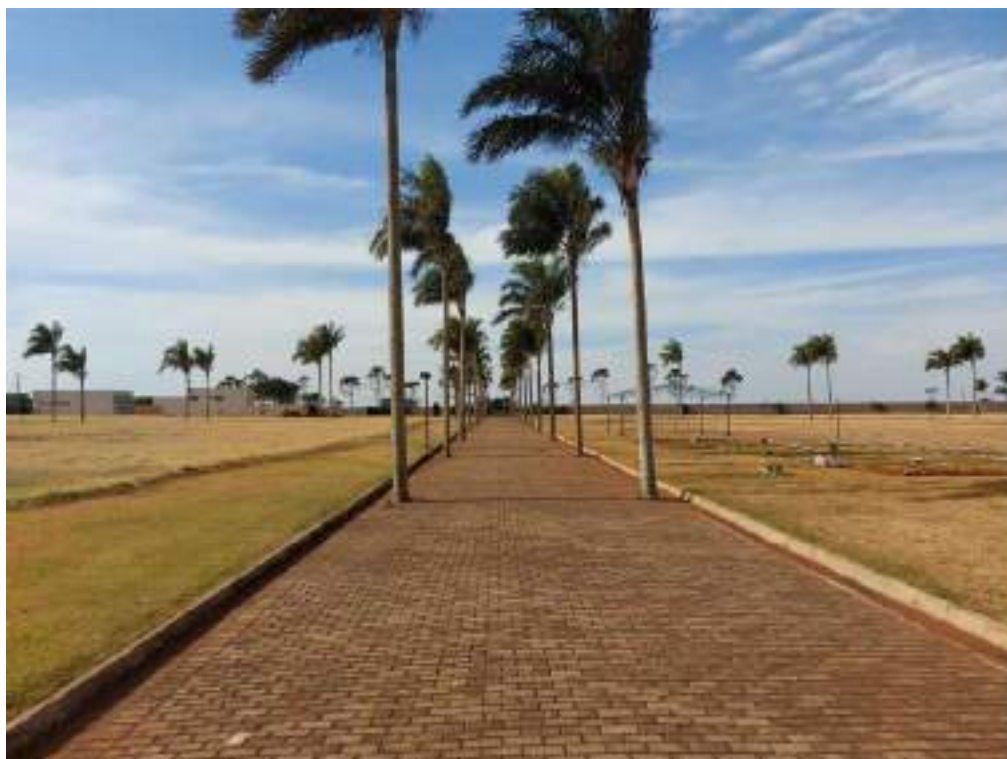
Figura 162: Arruamento interno cemitério.
