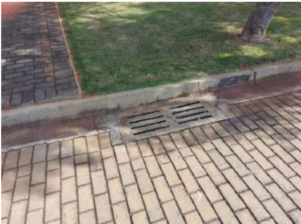
Figura 154: Bueiro do arruamento do cemitério.
