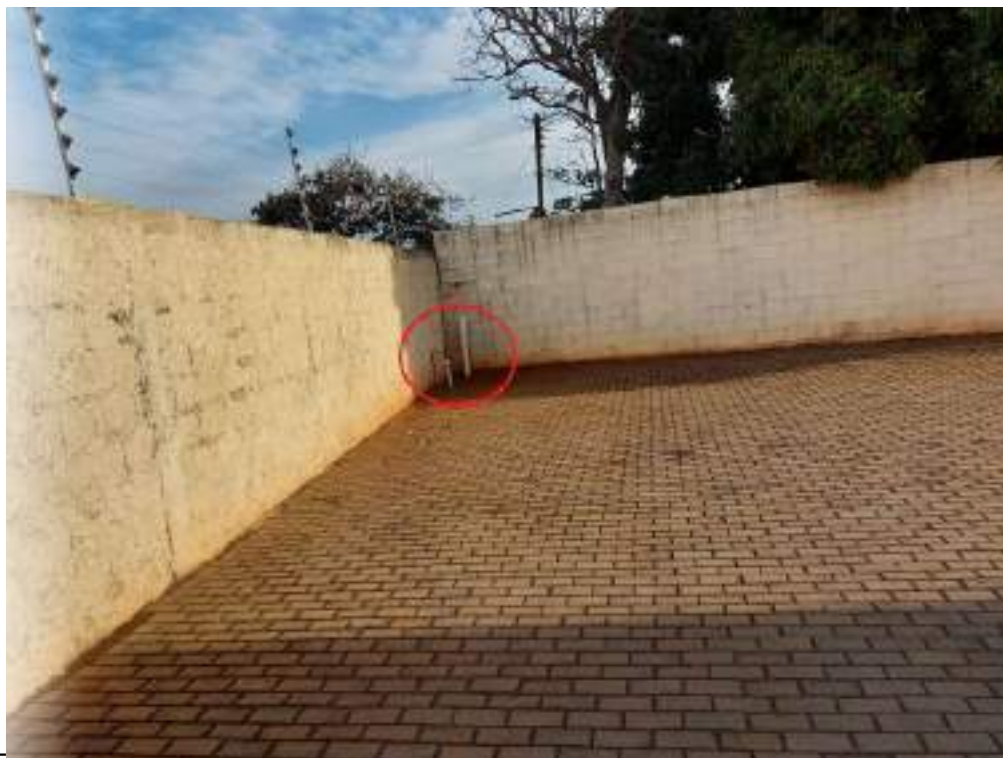
Figura 138: Fossa séptica e sumidouro da infraestrutura de velório.
