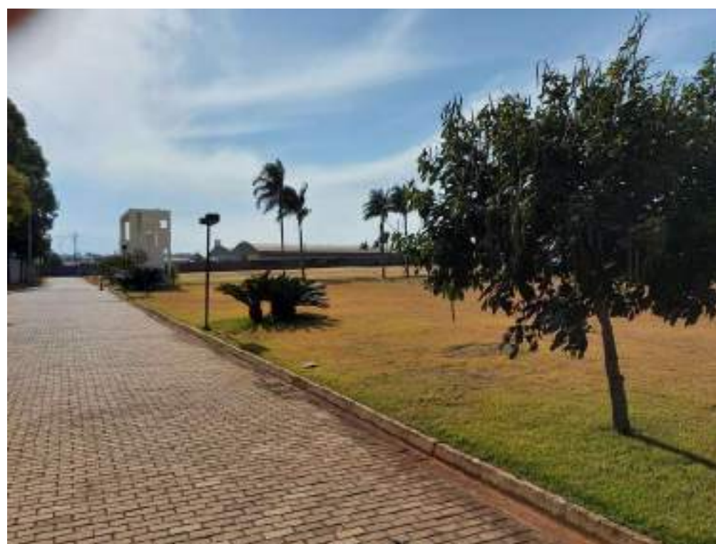
Figura 152: Arruamento interno cemitério.
