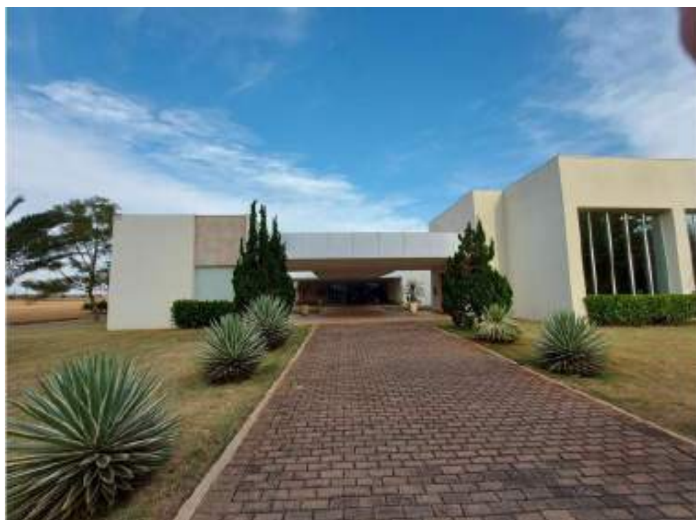
Figura 35: Pista de entrada e jardim.
