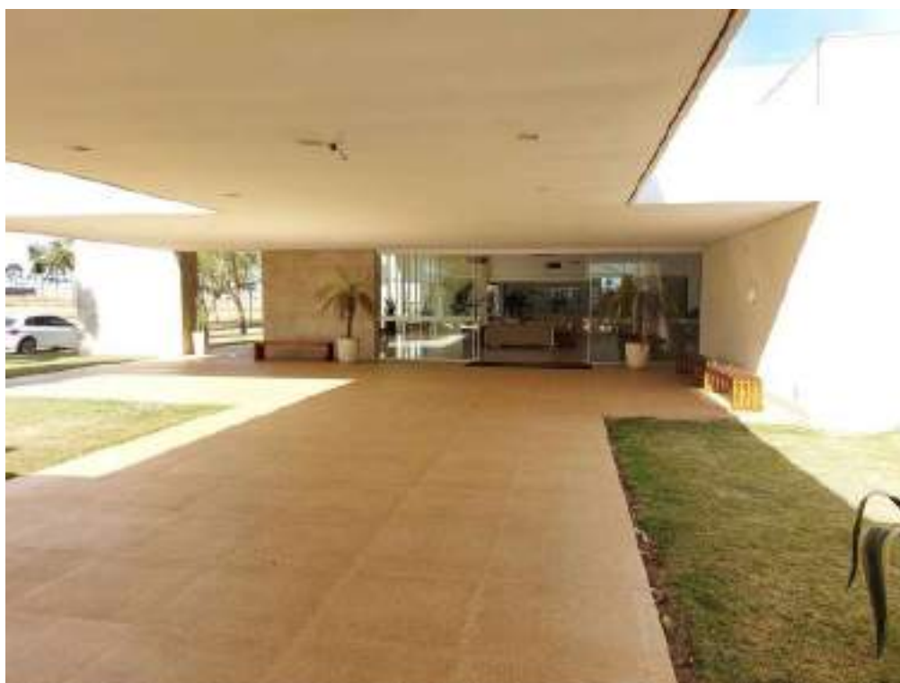
Figura 49: Corredor de acesso ao salão.
